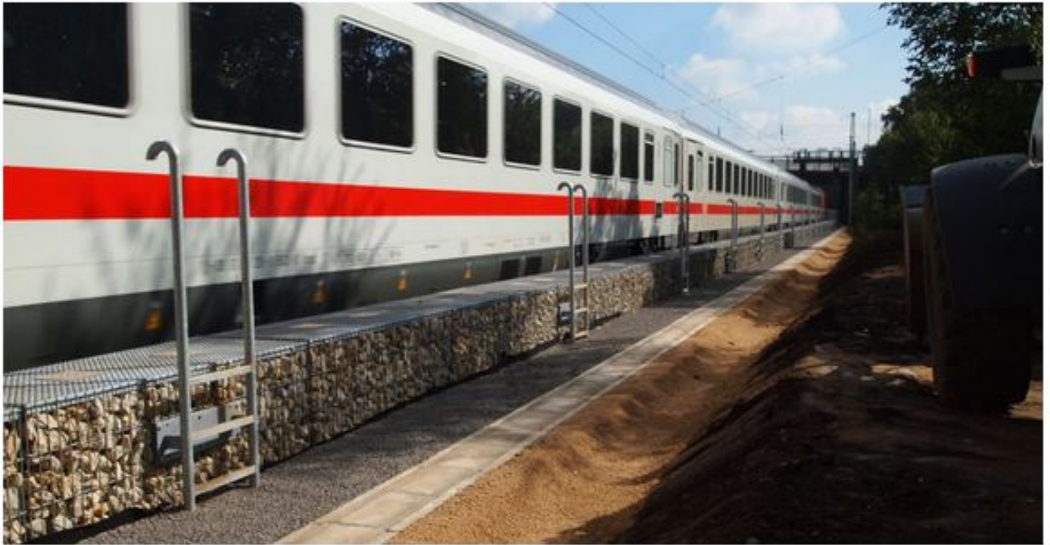
nSSW Bauart Gabione, Typ „Silenzio Forte“ in Andernach
